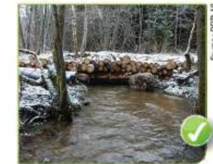
Ponceau en rondins
