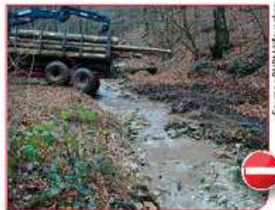
Érosion progressive des berges au niveau du gué.
