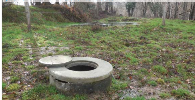
Au premier plan, on observe le regard qui permet de réguler l'eau pour les abreuvoirs situés en contre bas
