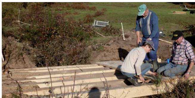
Construction d'une passerelle
