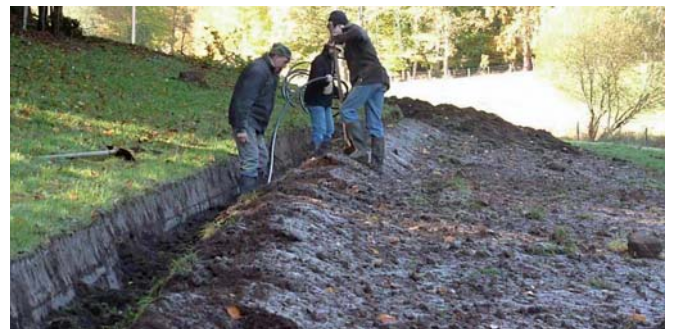
Mise en place du réseau d'adduction d'un abreuvoir gravitaire
