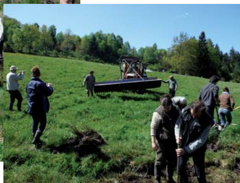
Installation de l'arche PEHD dans le ruisseau
