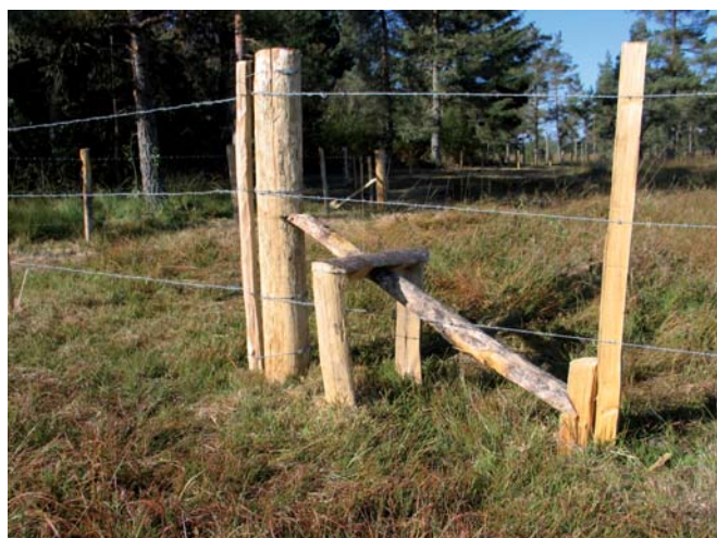
Pour faciliter l'accès à la zone humide, il est possible d'installer un « sautadour » rustique lors de l'installation d'une clôture neuve.
