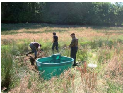
Mise en place d'un abreuvoir, création d'une tranchée pour le trop-plein et l'alimentation
