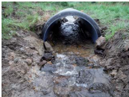
La demi-buse en PEHD avant remblais
