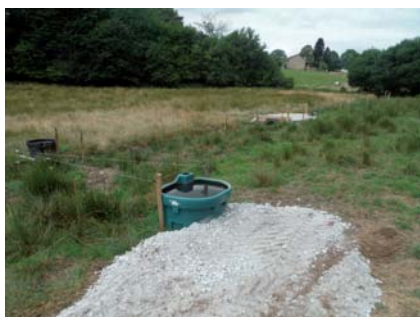
L'aménagement terminé : les deux abreuvoirs, le ponceau et la zone humide
