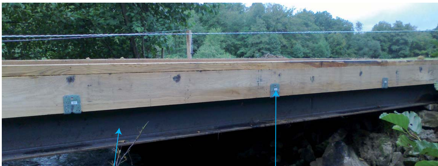
Poutrelle HEA (profil en H couché)
