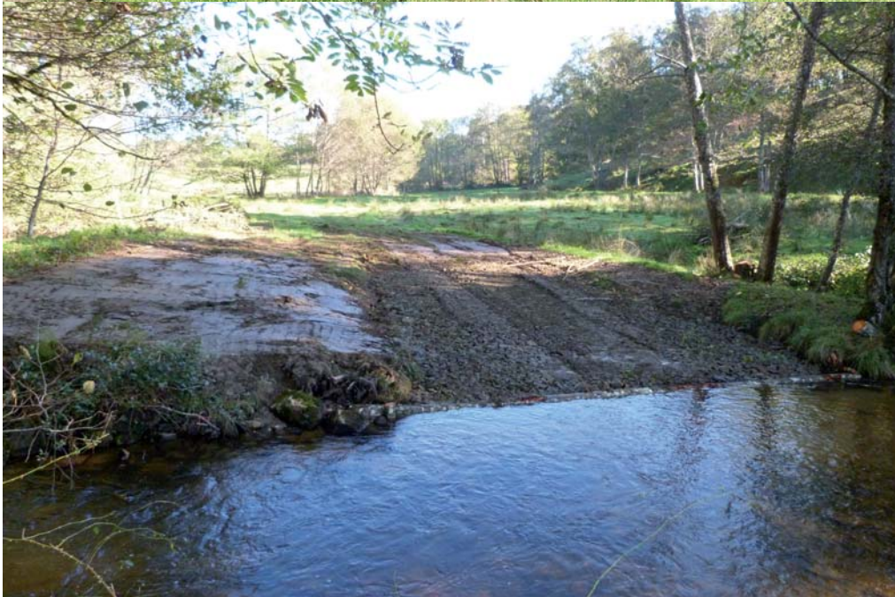
Après travaux rive gauche
