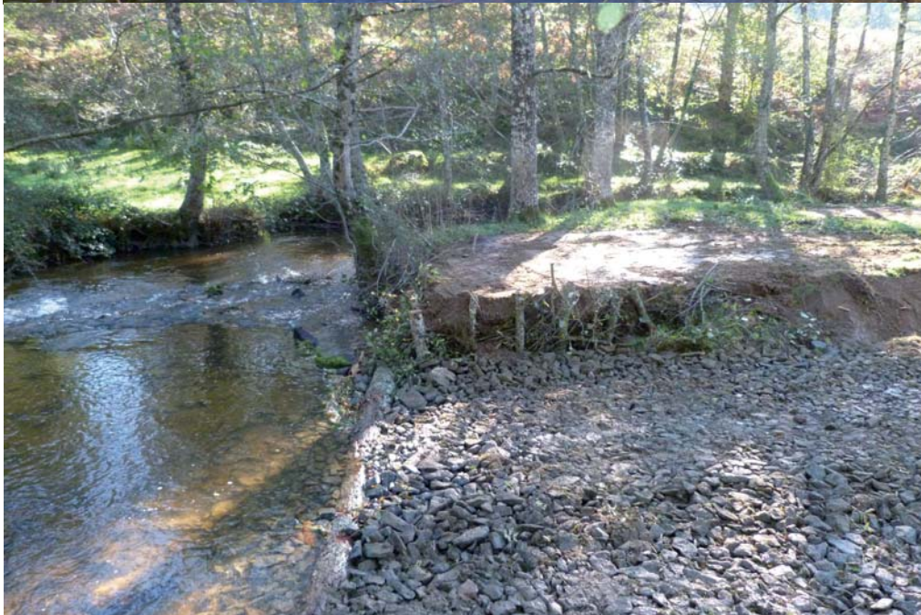
Après travaux rive droite
