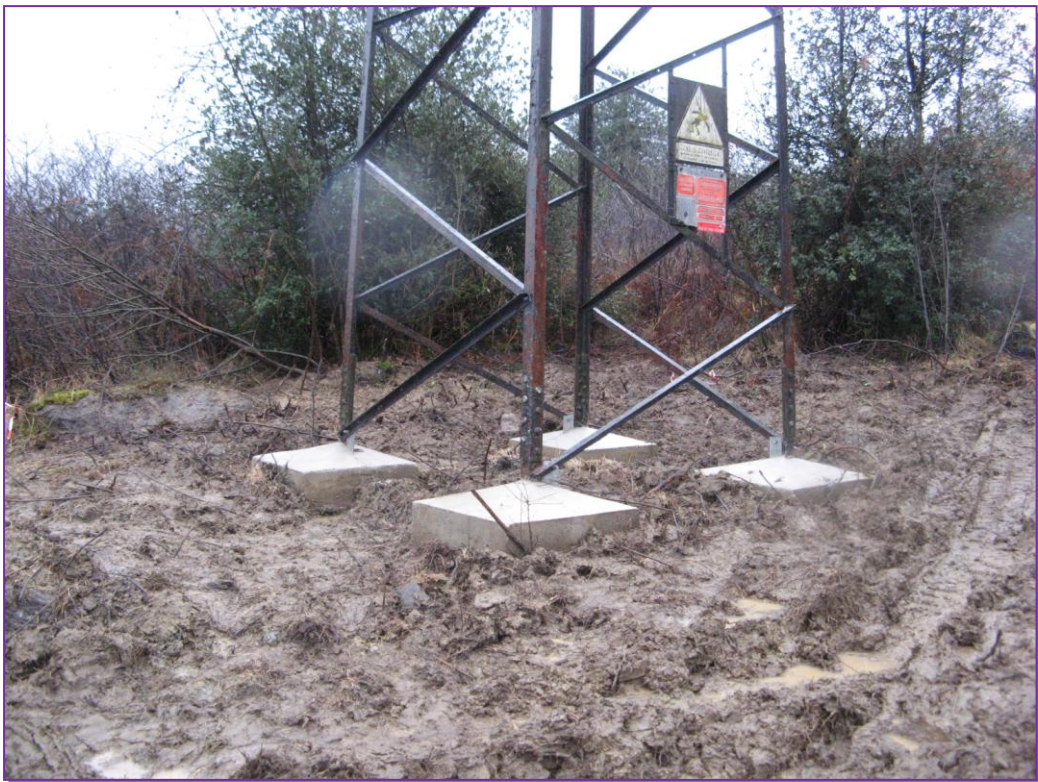
Un pylône sur ses 4 plots tout neufs...
